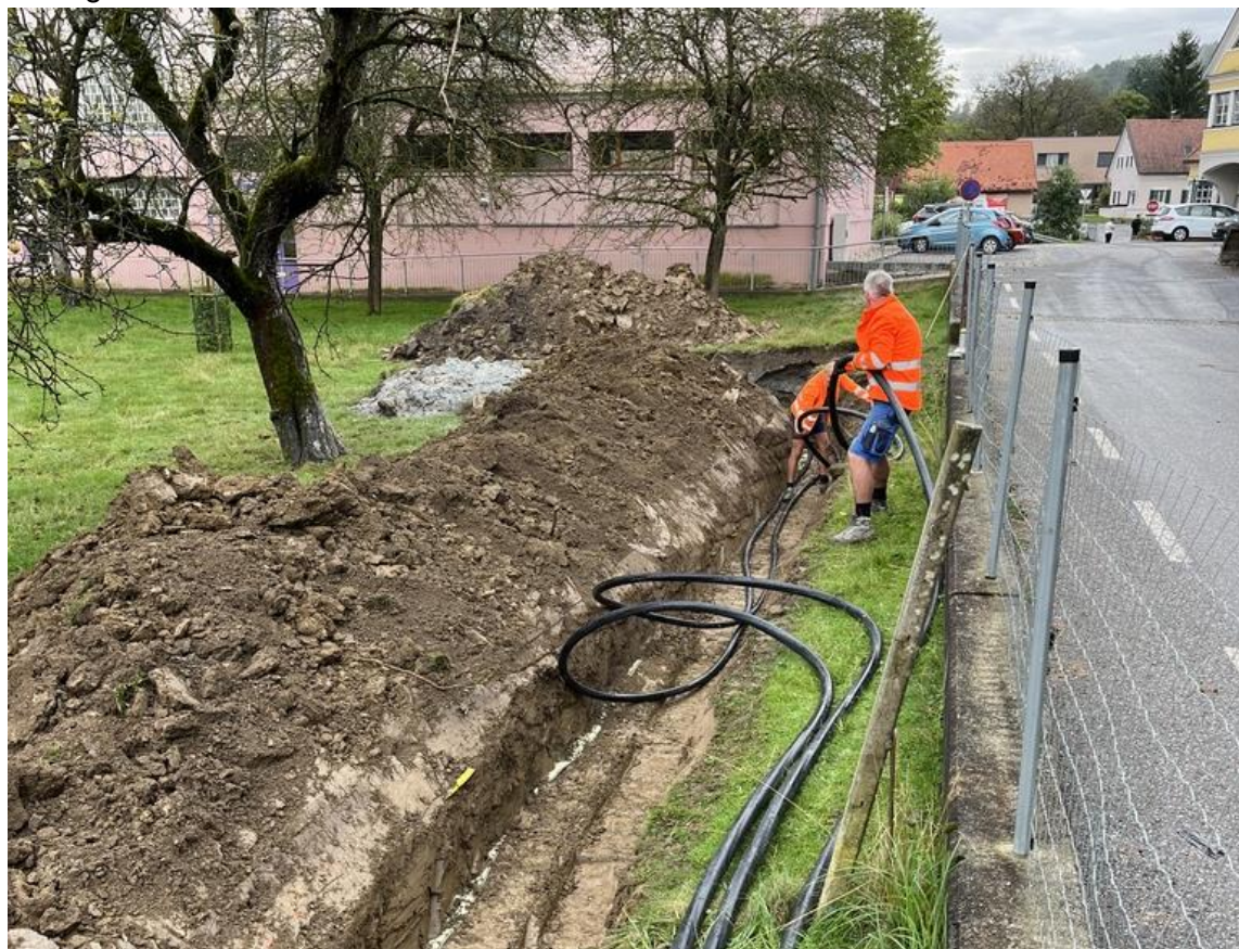
Abbildung 2: Verlegung der neuen Erdkabel © Gemeinde Mitterdorf an der Raab
